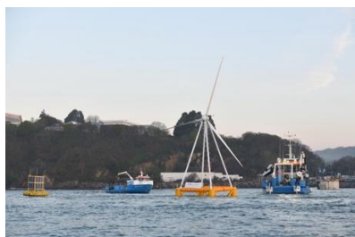
Installation de l'éolienne flottante Eolink (échelle 1-10ème) à Sainte-Anne du Portzic
